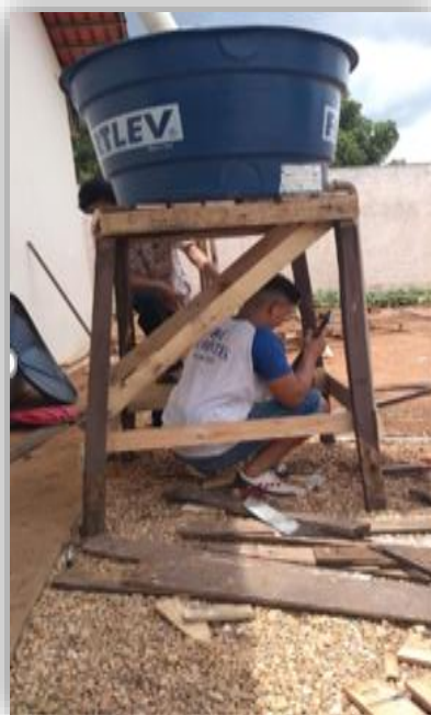
Figura 10 – Construção da base da caixa d'água para o sistema de irrigação
