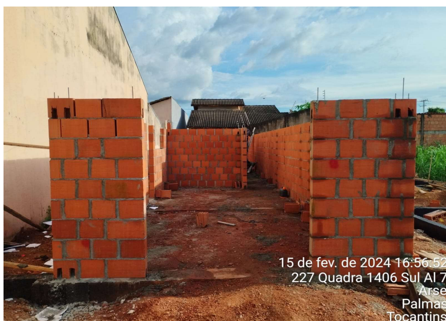
Figura 3 – Levante de blocos de alvenaria estrutural.
