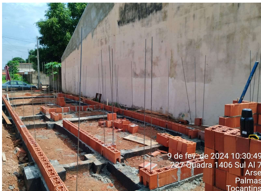
Figura 2 – Início Levante e Modulação de blocos de alvenaria estrutural.
