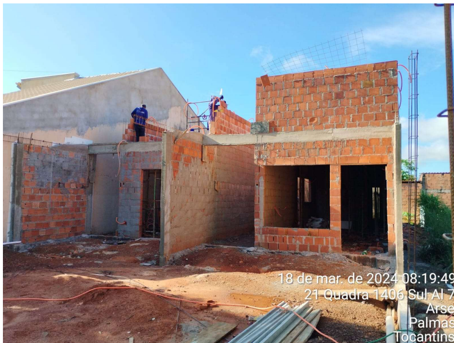
Figura 5 – Levante de blocos de alvenaria estrutural.
