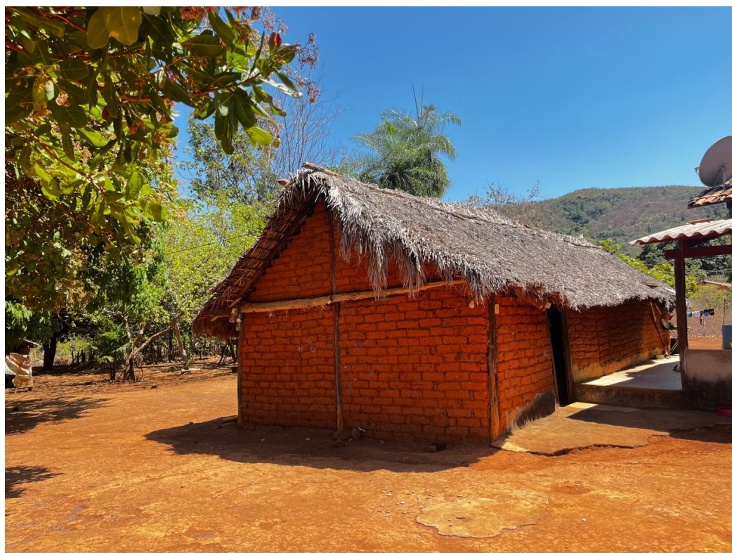
Figura 4 – Tipologias habitacionais e estrutura das moradias na Comunidade Córrego Fundo.
