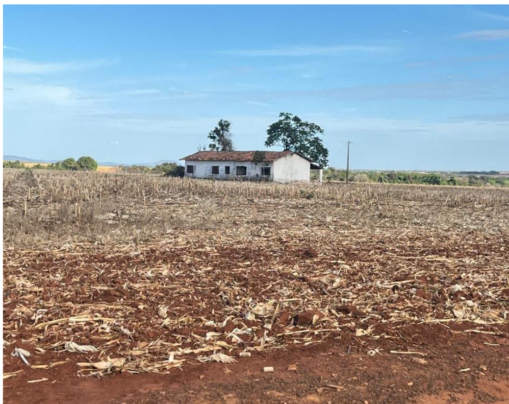
Figura 3 – Estruturas da escola comunitária desativada da Comunidade Quilombola Córrego Fundo, circundada por área de monocultura sem zona de amortecimento.
