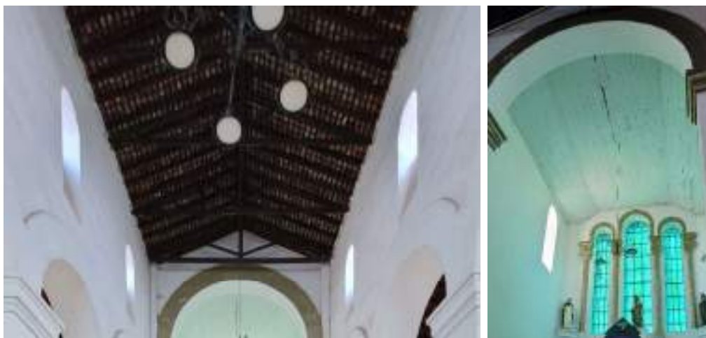
Figura 41 – Elementos estruturais de madeira, Porto Nacional – TO
