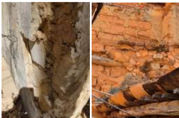
Figura 42 – Rebocos externos em edificações de Natividade e Porto Nacional – TO
