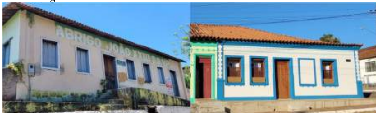
Figura 44 – Imóveis em alvenaria de terra nos centros históricos estudados
