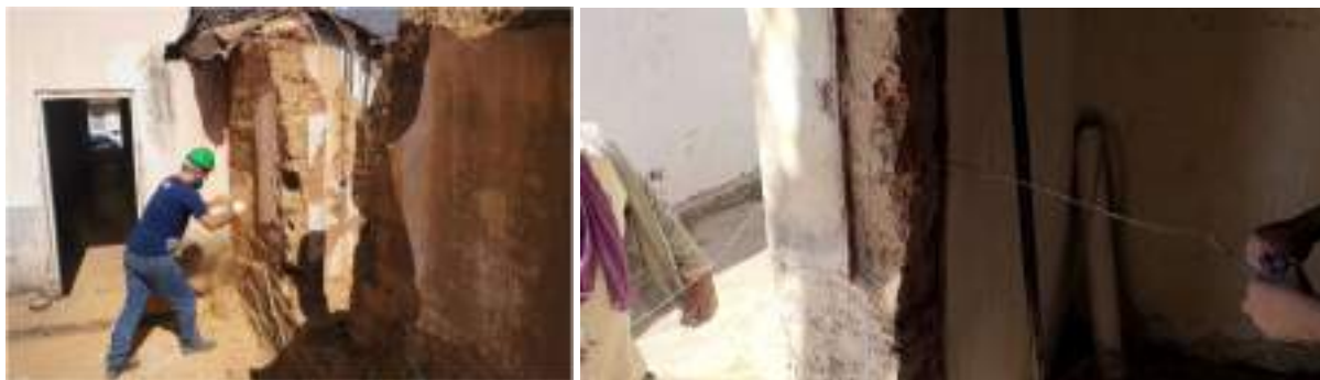
Figura 38 – Corte em parede de adobe, Natividade – TO
