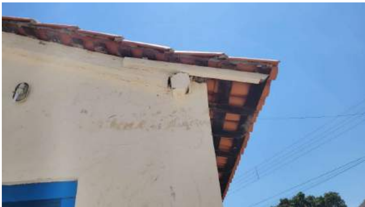
Figura 34 – Cachorro, frechal e telha colonial em cobertura tradicional, Natividade – TO
