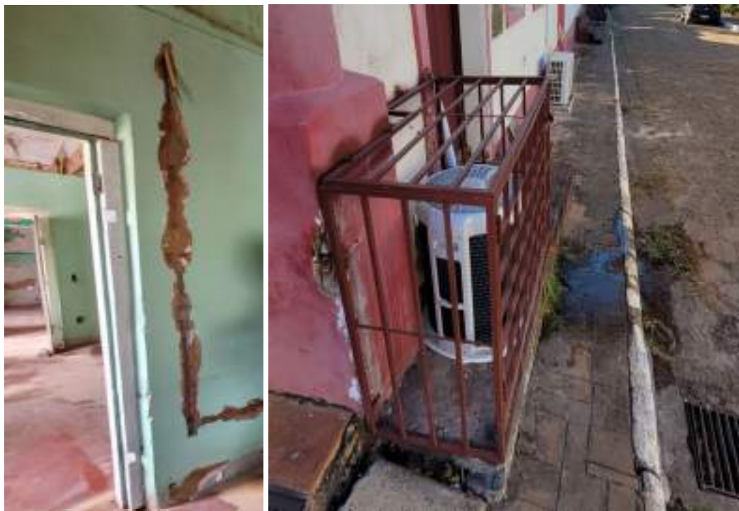
Figura 43 – Eletroduto e condensadora do ar-condicionado, Natividade – TO
