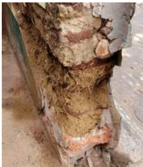
Figura 33 – Adobes de ampliações do imóvel 4
