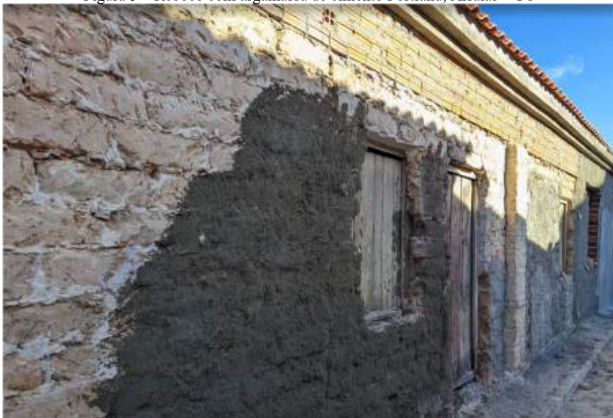
Figura 5 – Reboco com argamassa de cimento Portland, Arraias – TO
