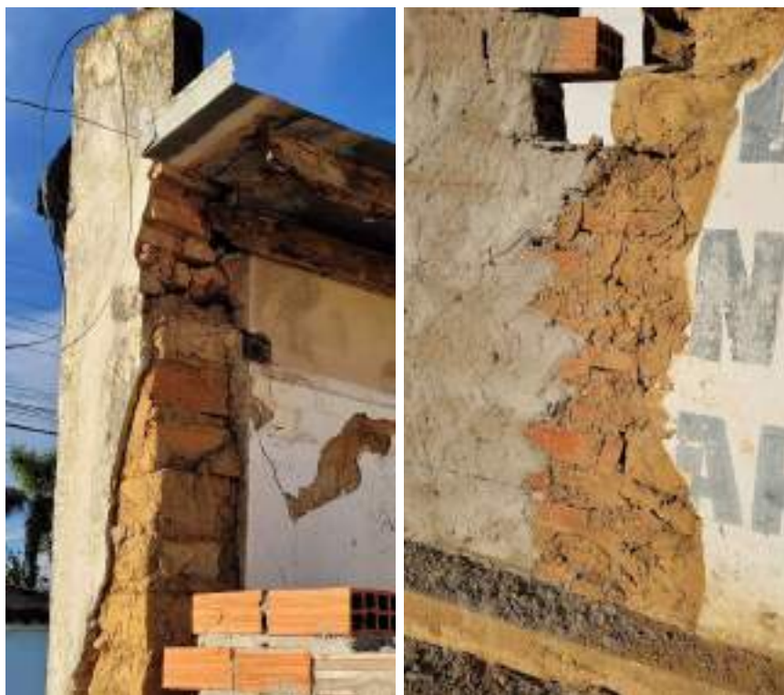
Figura 40 – Associação entre alvenaria convencional e adobe, Porto Nacional – TO
