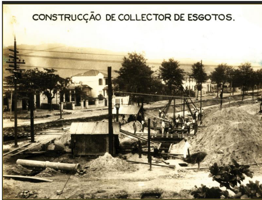
Figura 1 – Construção de Coletor de Esgotos em Santos (São Paulo)
