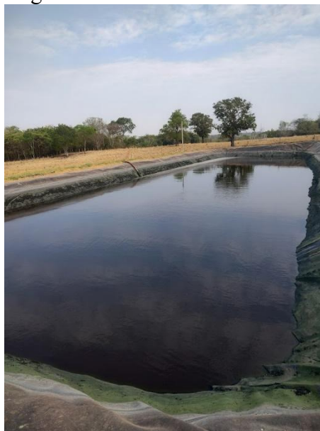
Figura 4 - Lagoa de sistema de tratamento do abatedouro.
