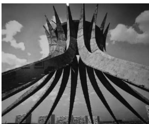
Figura 11: Estrutura de sustentação da Catedral de Brasília, ainda em fase de construção. Brasília, Brasil.
