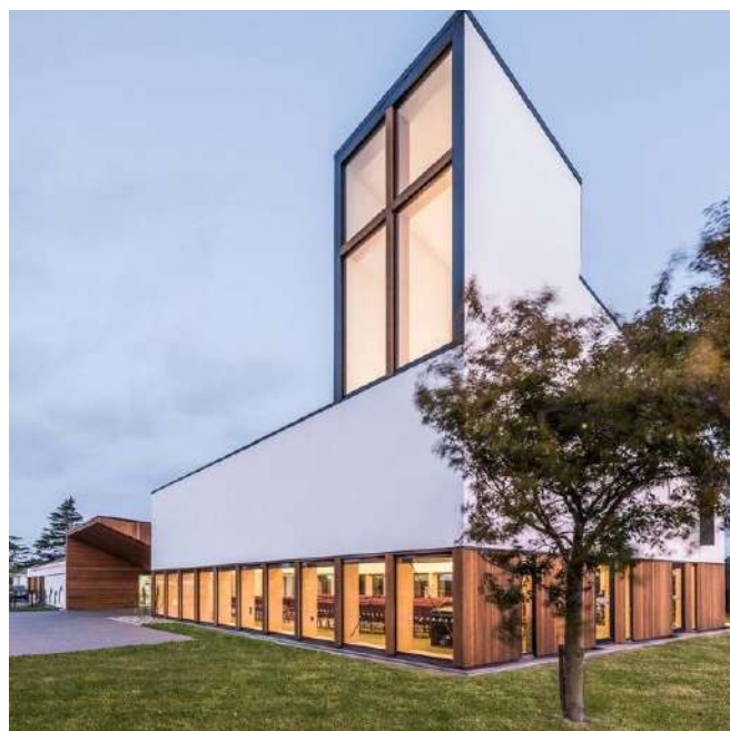
Figura 8: Destaque à torre principal localizada na esquina da edificação. Christchurch, Nova Zelândia.
