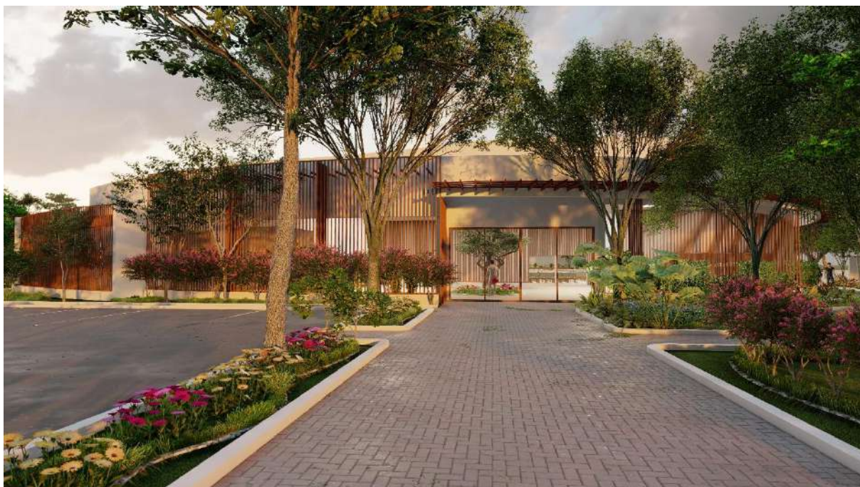
Figura 46: Fachada Edifício Templo (Oeste)
