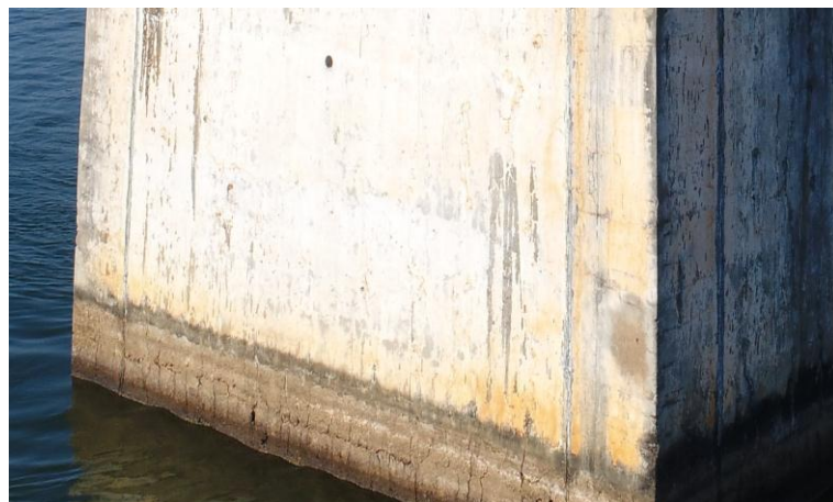
Figura 22: Abrasão por atrito com a água e fissuras na face Fátima em P4
