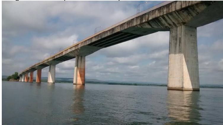
Figura 1: Visão panorâmica da ponte sobre o Rio Tocantins.
