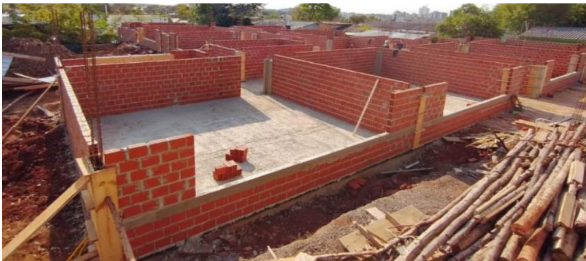
Figura 22 – Levantamento das paredes de alvenaria convencional
