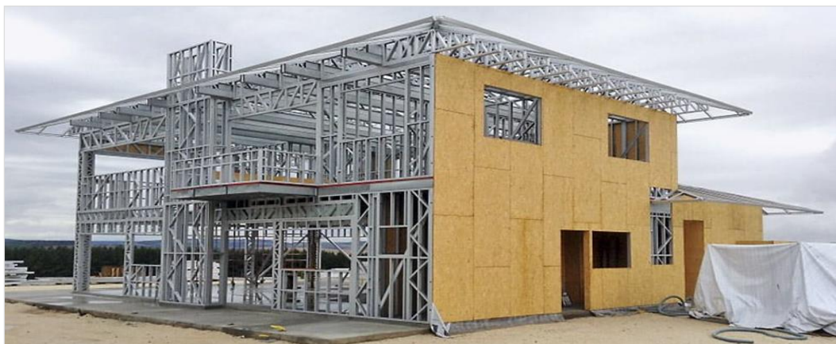
Figura 1- Edificação de Steel Frame em construção
