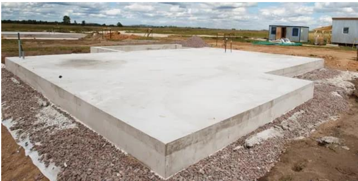
Figura 5 - Fundação em radier
