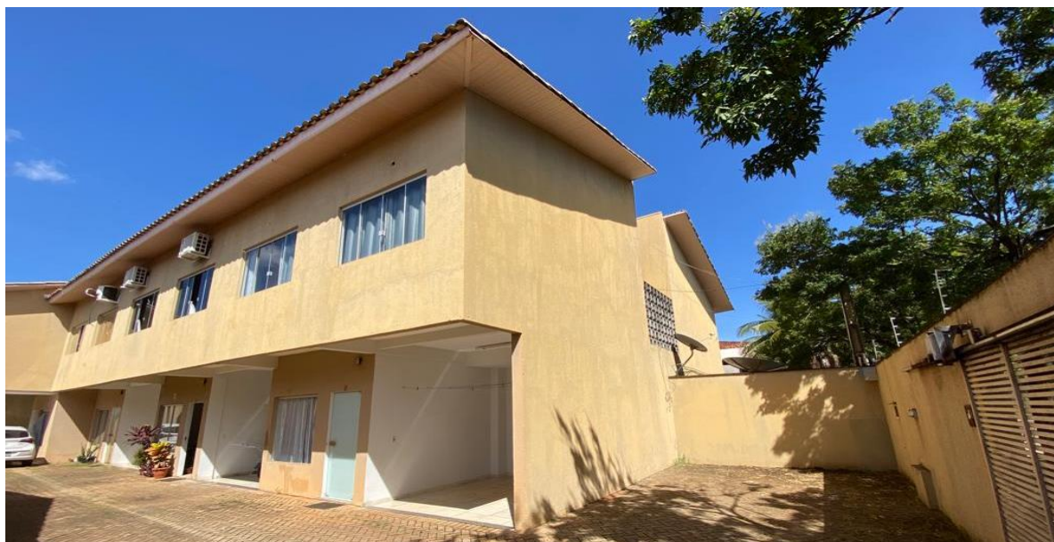
Figura 38 - Fachada da edificação de Alvenaria Convencional
