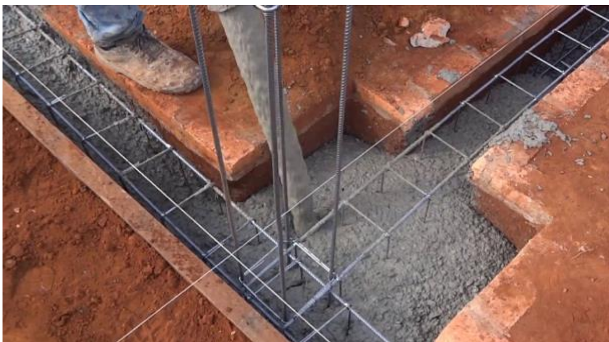
Figura 20 - Concretagem de viga baldrame
