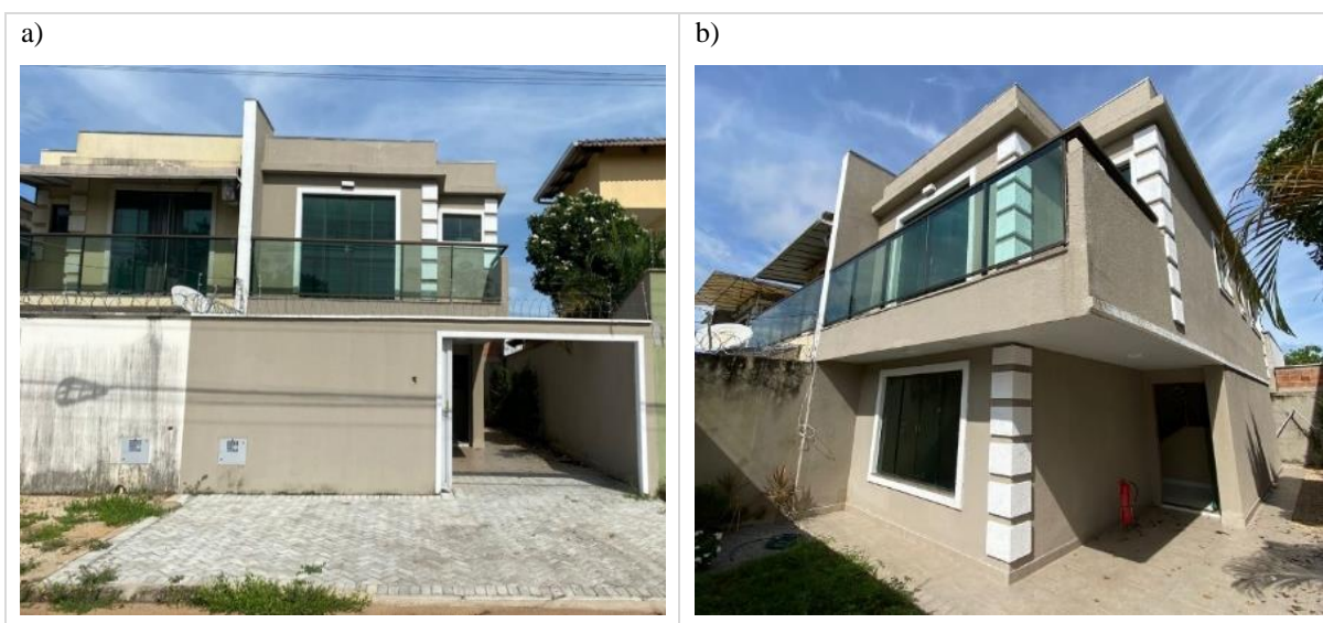
Figura 37 - a) Lote da residência de Steel Frame e b) Fachada da residência de Steel Frame
