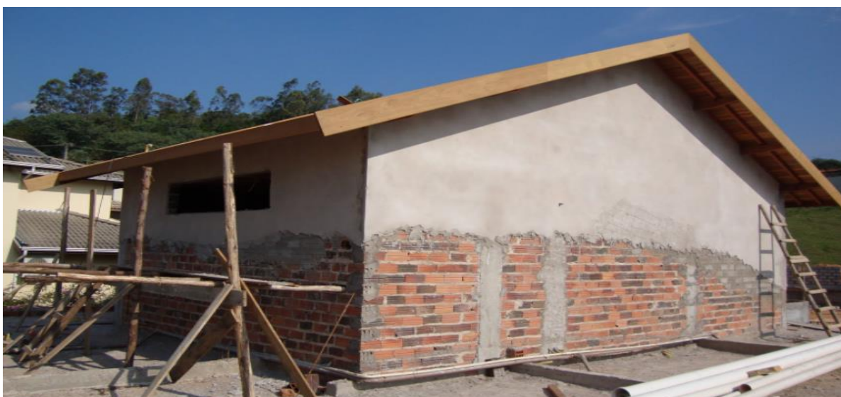
Figura 25 - Revestimento das paredes de vedação
