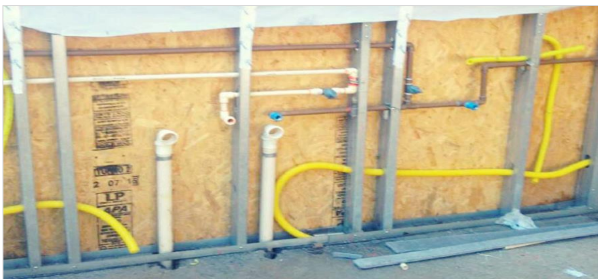
Figura 12 - Instalação elétrica e hidrossanitário numa parede de Steel Frame
