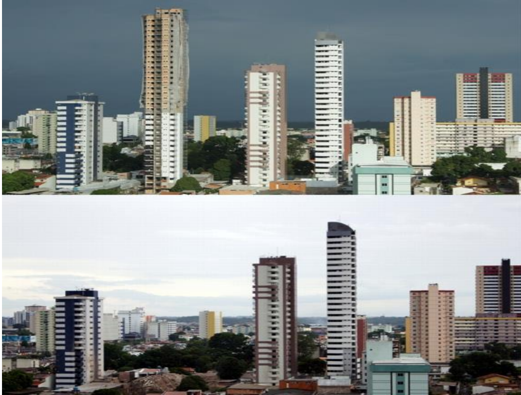
Figura 2.16 - Antes e depois do edifício Real Class
