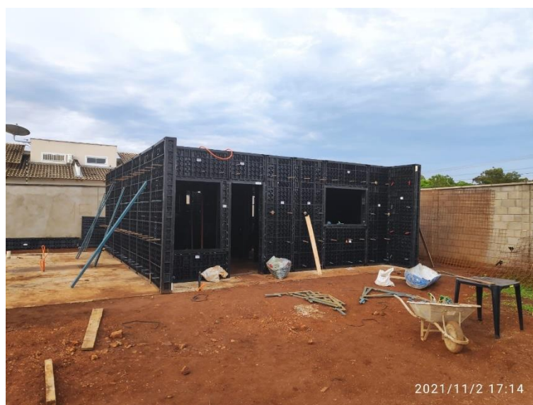
Figura 5 Fôrmas montadas para concretagem em Palmas - TO
