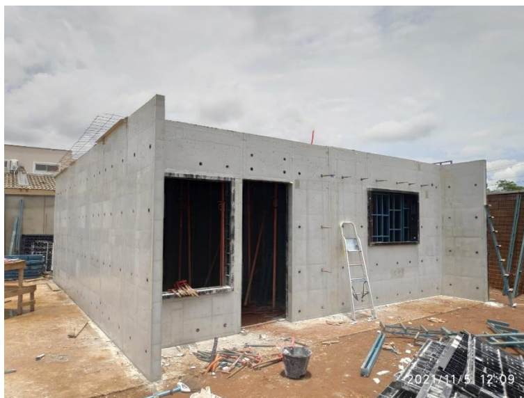
Figura 6 Desforma após 3 dias de concretagem em Palmas - TO
