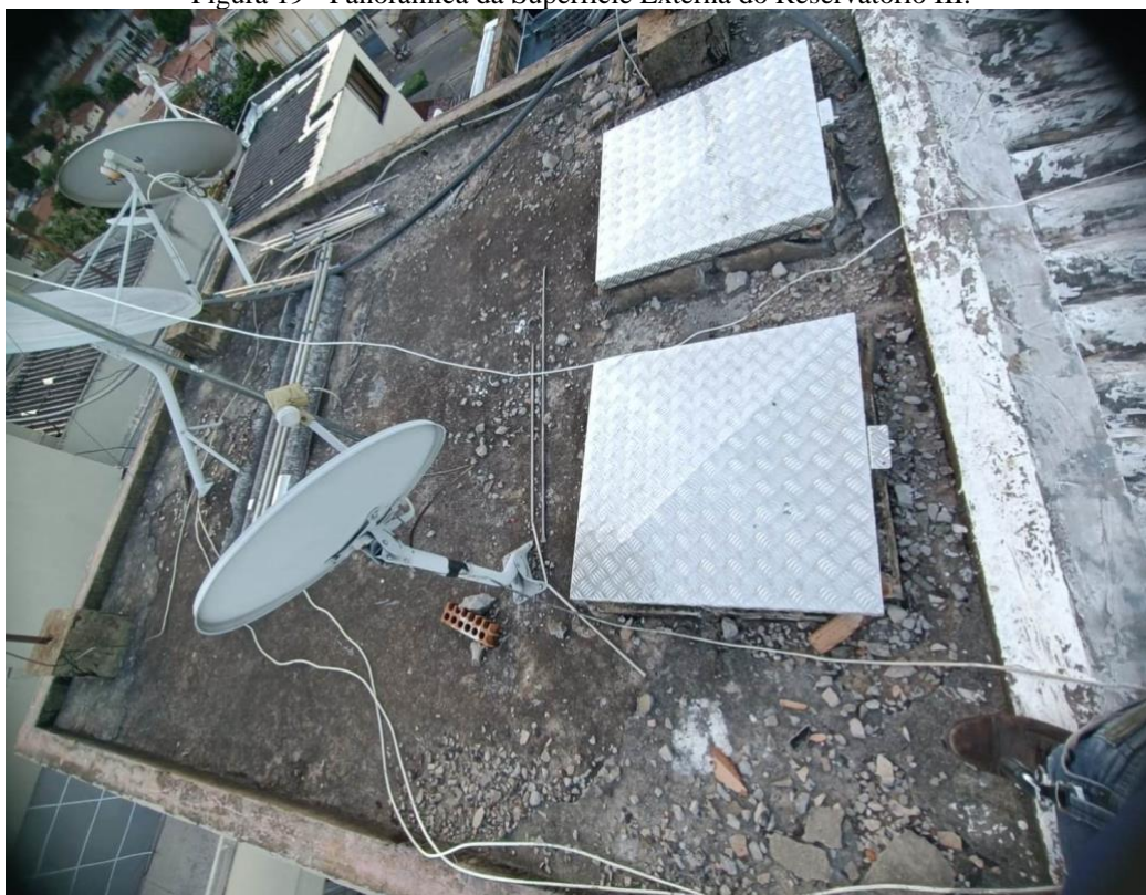
Figura 19 - Panorâmica da Superfície Externa do Reservatório III.
