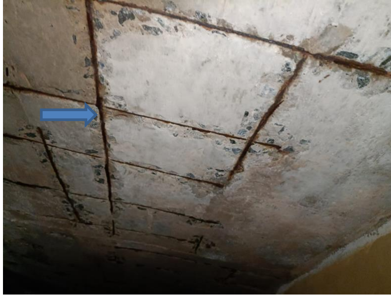
Figura 21 - Lado esquerdo do interior da Laje do Reservatório III.
