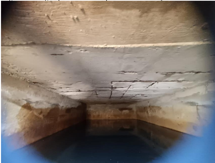
Figura 10 - Imagem panorâmica da Superfície Interna da laje do Reservatório I.
