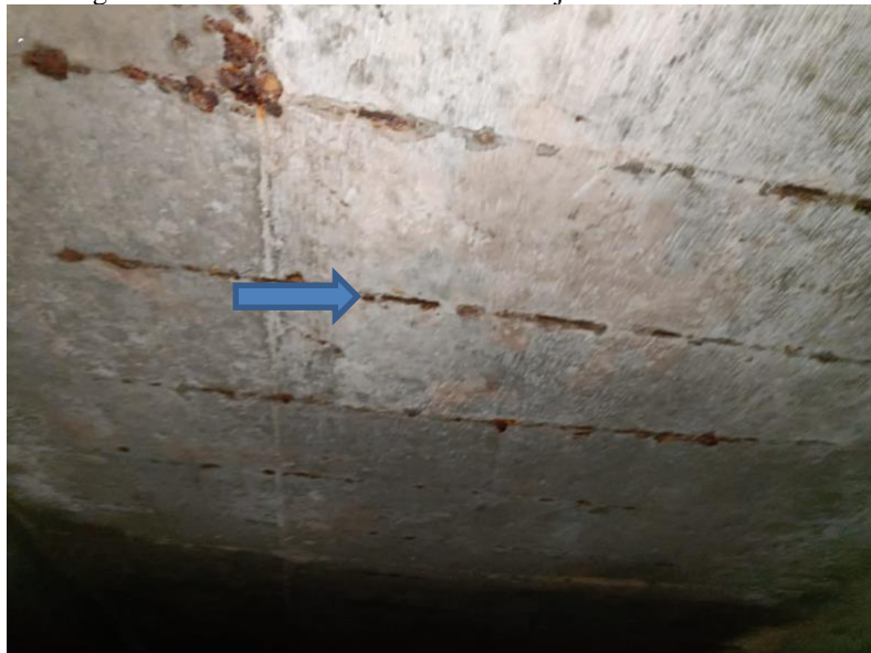
Figura 22 - Lado direito do interior da Laje do Reservatório III.
