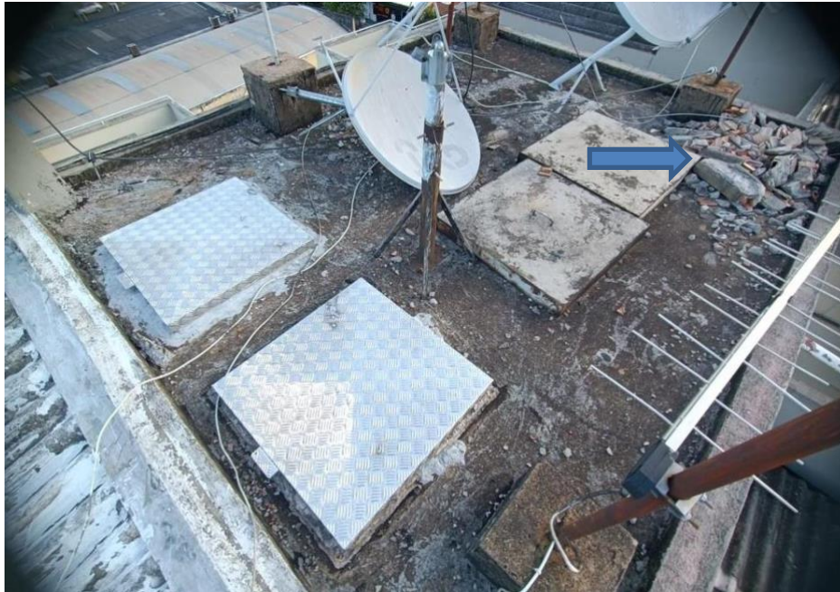
Figura 14 - Panorâmica da Superfície Externa do Reservatório II.
