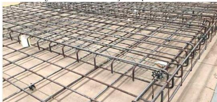
Figura 1 - Armaduras de laje maciça.
