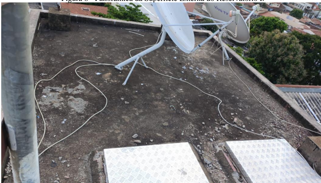
Figura 8 - Panorâmica da Superfície Externa do Reservatório I.
