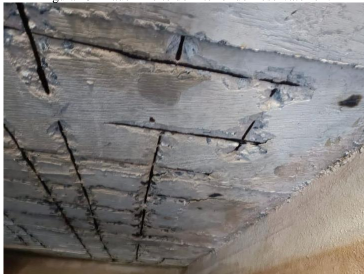
Figura 13 - Lado Direito do Interior do Reservatório I.
