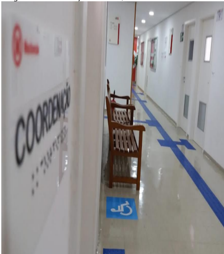
Imagem 25 - Identificação em Braille, Portas
