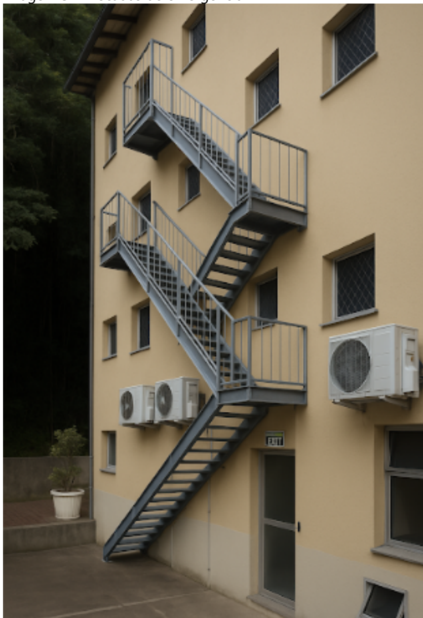
Imagem 52 - Escadas de emergência
