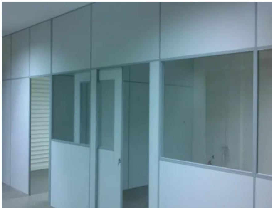
Imagem 24 - Portas com visores e paredes com 50% divisórias e 50% transparência Fonte:
