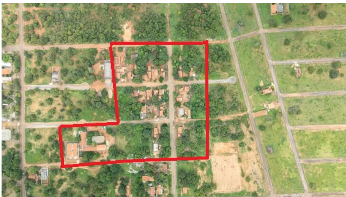
Fig. 16 – Vista aérea atual do entorno do Jardim dos Ipês 2.
