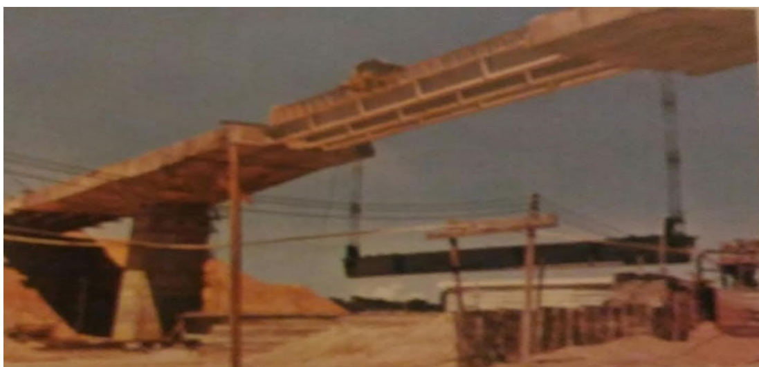
Fig. 3 – Construção da ponte sobre o rio Tocantins em Porto Nacional (vista terrestre).
