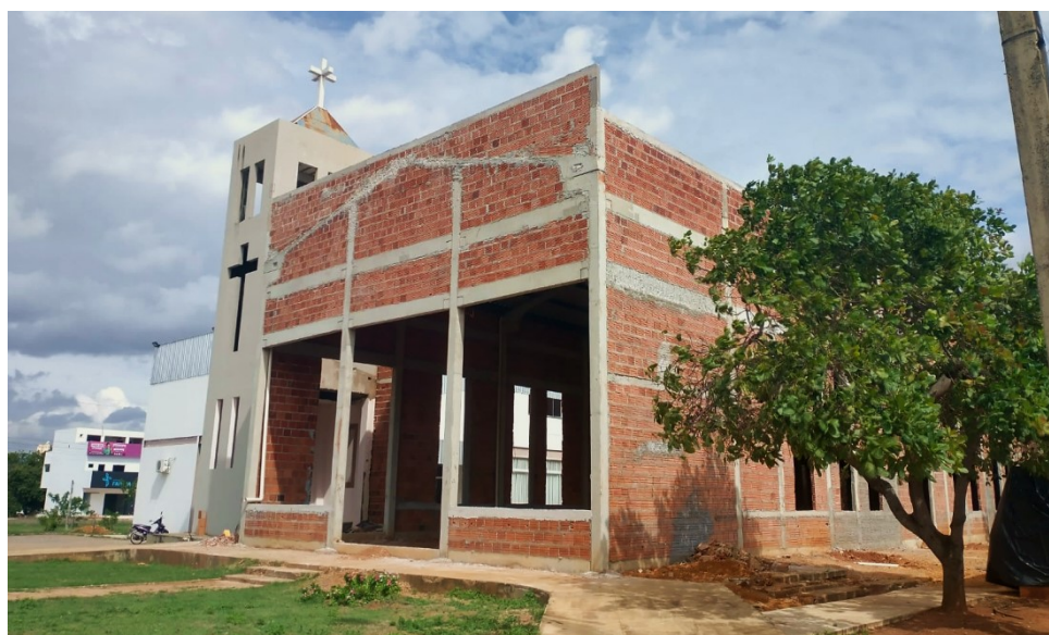
Figura 1 - Obra da Paróquia Coração de Maria, na ARSO 32
