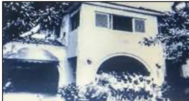
Figura 13 – Instituto Domingo Sávio Surdos Mudos na Av. Entrada do Arraial, 3379, em Casa Amarela
