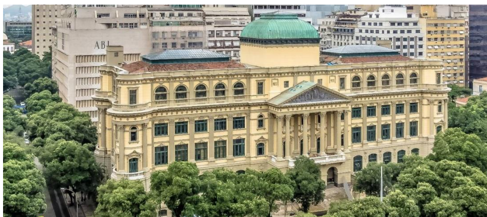
Figura 1: Atual edifício da Biblioteca Nacional – RJ. Fonte: Google imagens.
