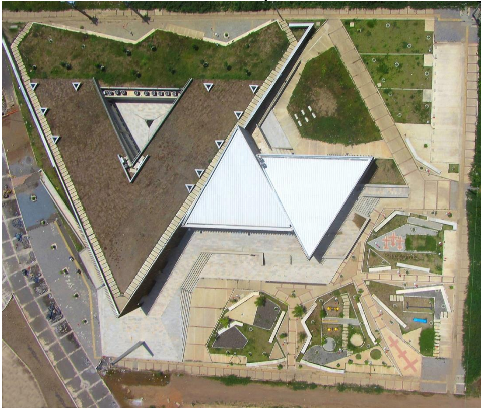
Figura 11:Fotografia aérea. Fonte: Archdaily, 2014.
