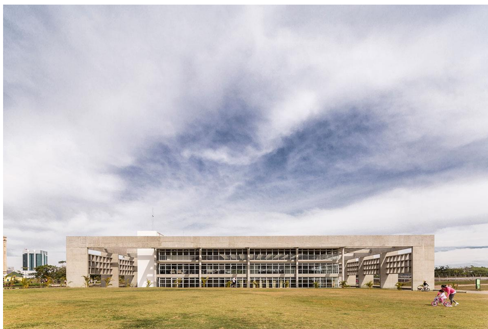
Figura 27: Pavilhão central. Fonte: Revista Projeto, 2014.
