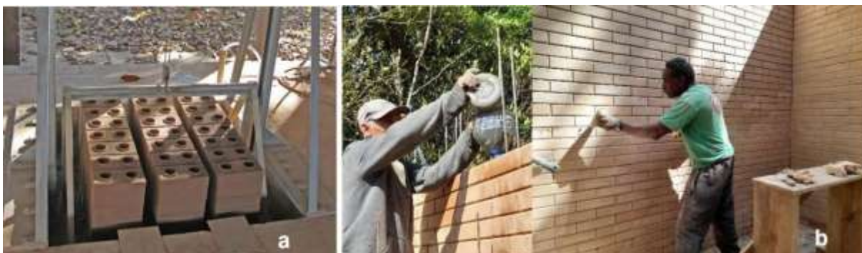
Figura VII – a) BTC, b) Enchimento e rejunte de parede com BTC da Casa Verdes Colinas, Santa Catarina
