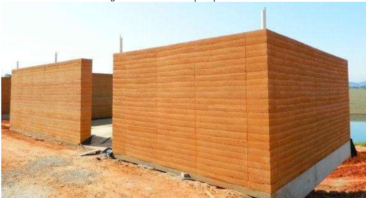
Figura VIII – Parede de taipa de pilão modernizada
