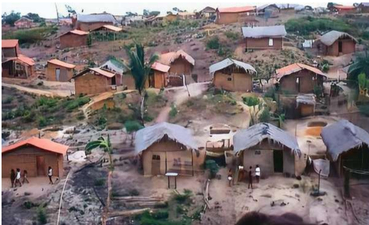
Figura II – Construções de taipa de mão na Vila Irmã Dulce, em Teresina (PI)
