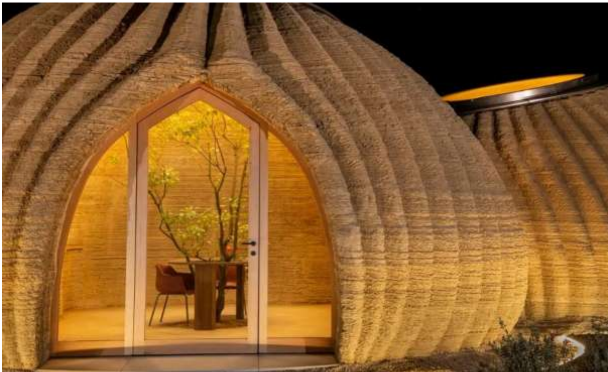
Figura IX – Protótipo da TECLA, primeira casa impressa em argila
