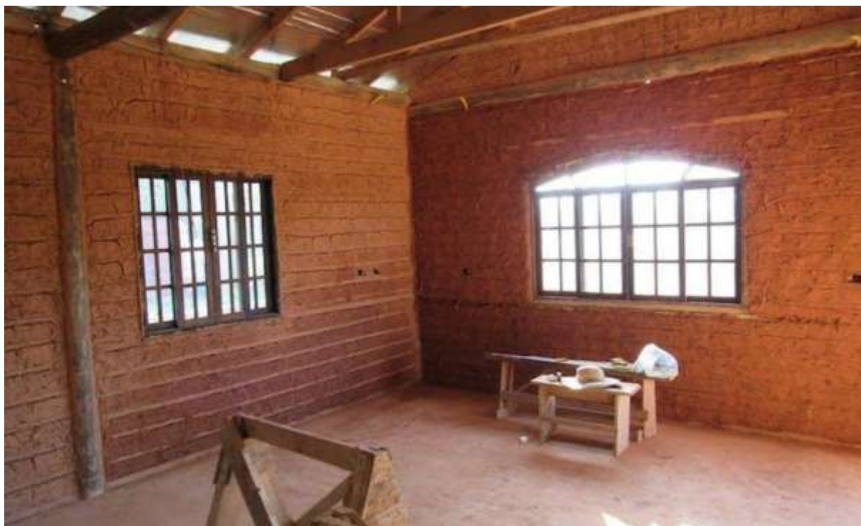
Figura V – Paredes de pau a pique da Casa Ser Cósmico, Paraná
