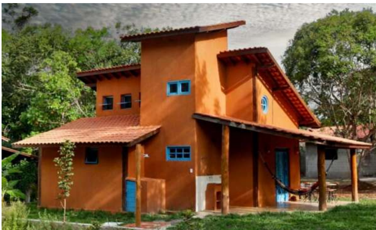
Figura III – Casa Três Jóias – Taipa De Mão no Recôncavo Baiano
