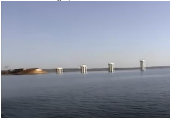
Figura 16 - Tocantins: início da construção da Ponte da Amizade e da Integração
