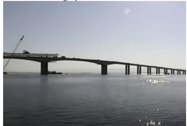
Figura 17 - Tocantins: a construção da Ponte da Amizade e da Integração
