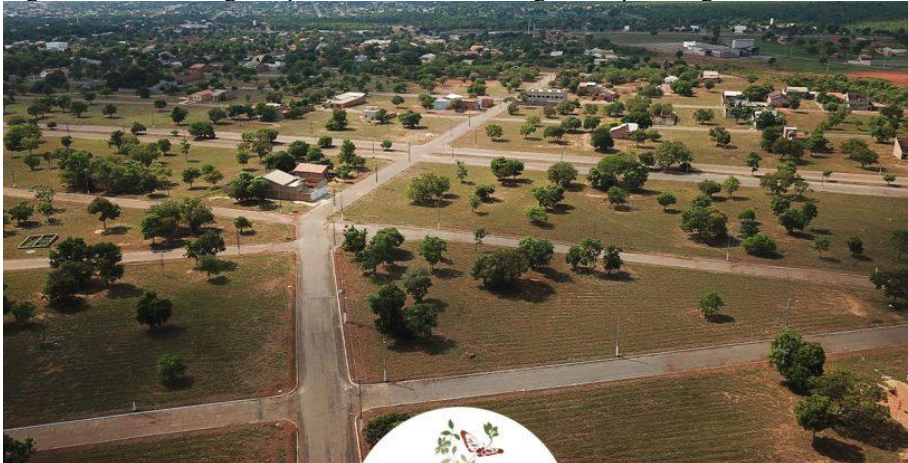
Figura 29 - Luzimangues: parte do loteamento Laguna I, que margeia a rodovia TO-080
