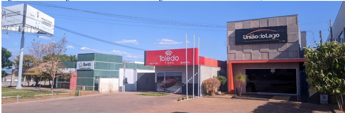
Figura 55 – Luzimangues: edifícios da União do Lago e da Buriti situados no distrito, 2025
