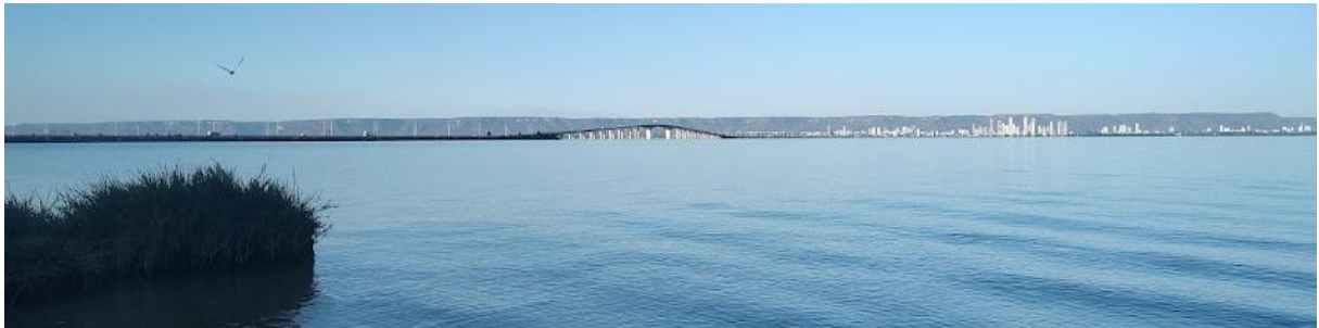
Figura 18 – Tocantins: ponte sobre o reservatório da UHE Luís Eduardo Magalhães entre Luzimangues e Palmas, em 2024
