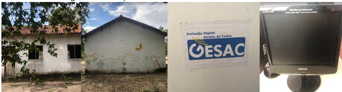
Figura 30 - Instalações do laboratório de informática GESAC na escola
