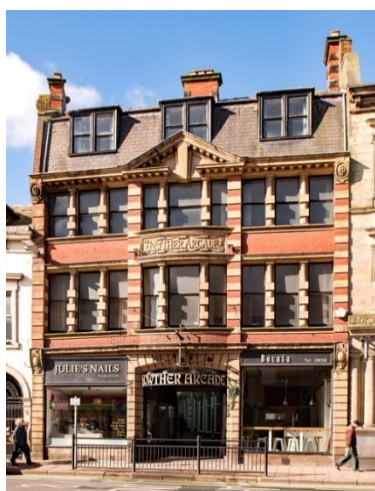
Figura 11 - Fachada da Lowther Arcade
