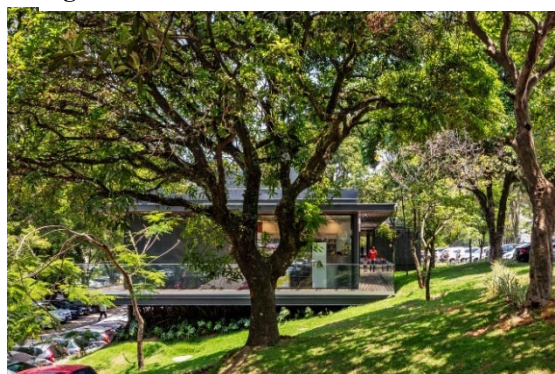
Figura 51 - Vista externa do edifício
