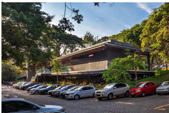
Figura 58 - Vista externa do estacionamento
