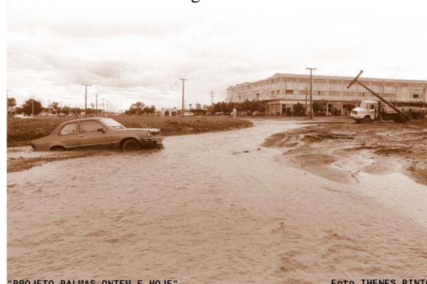
Figura 62 - Galeria Wilson Vaz diante de alagamentos
