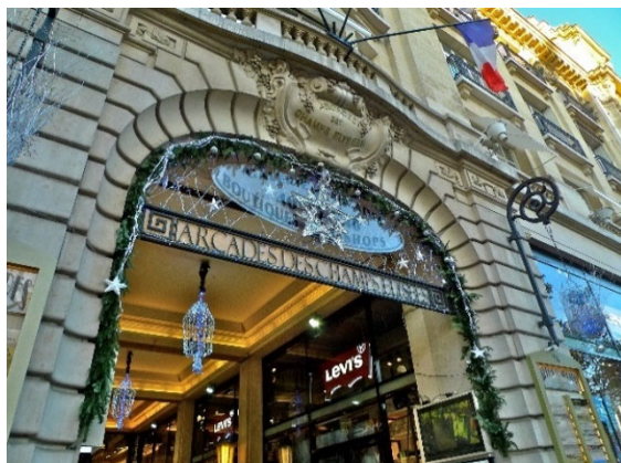
Figura 29 – Fachada da Galeria des Champs-Élysées Lido
