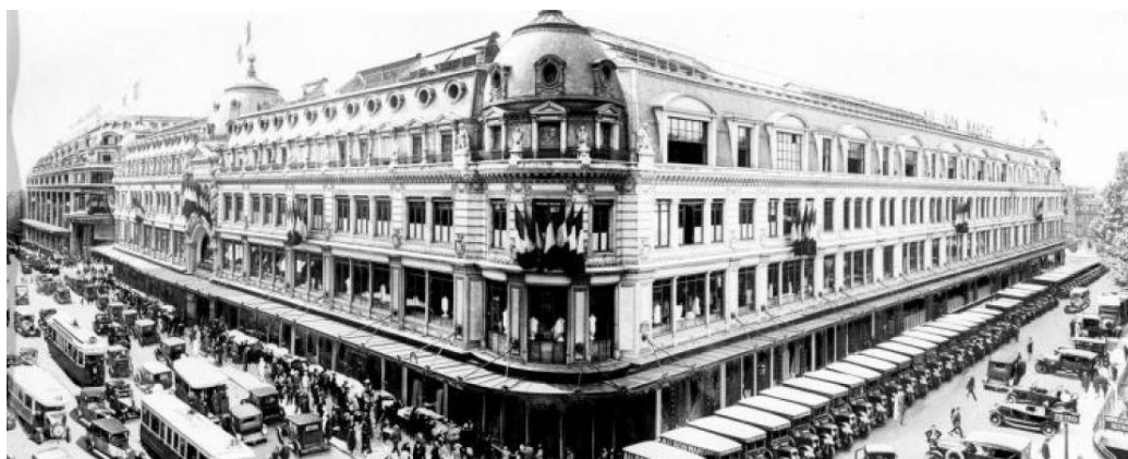
Figura 17 - Fachada do Bon Marché em Paris em 1920
