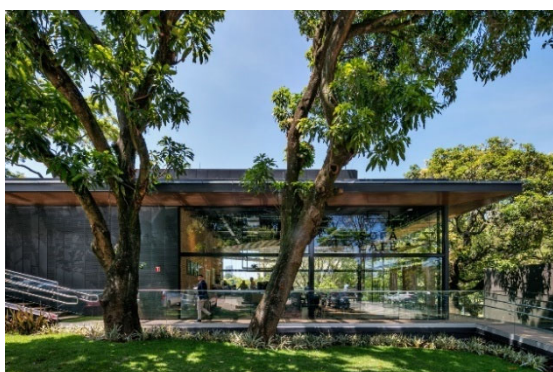
Figura 52 - Vista externa do edifício
