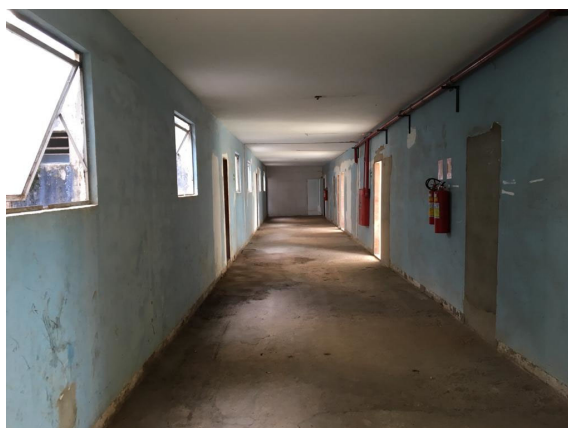
Figura 74 - Circulação pavimento superior (Área inutilizada)
