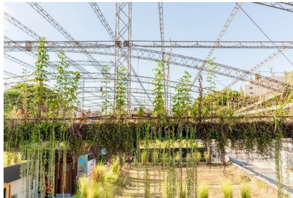
Figura 49 - Vista da cobertura verde e estrutura
