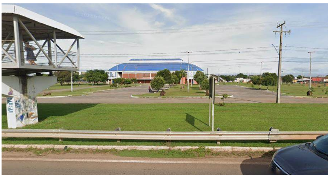
Figura 58 – Figura da vista lateral 2
