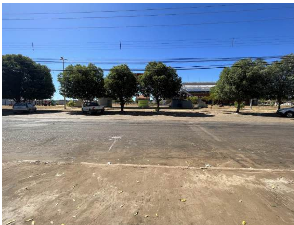
Figura 60 – Figura da vista lateral 4
