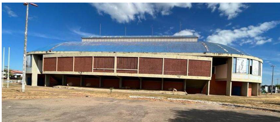
Figura 31 - Figura da fachada leste do Ginásio Ayrton Senna
