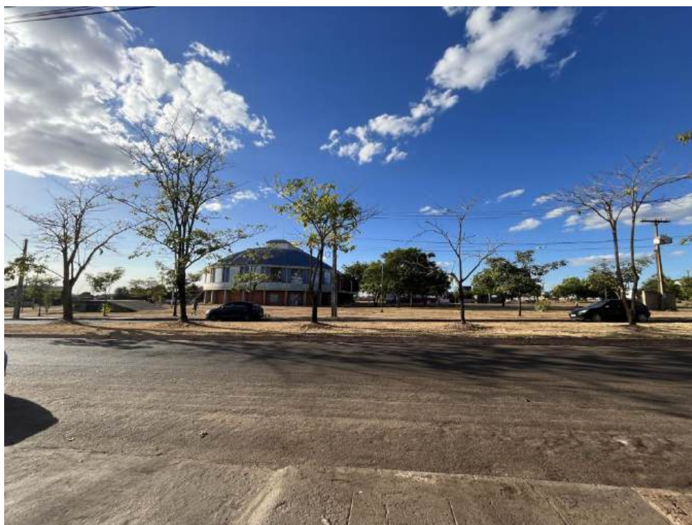
Figura 59 – Figura da vista lateral 3
