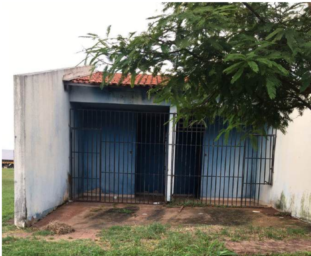
Figura 35 – Figura do banheiro da APM, local 5
