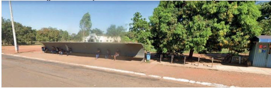
Figura 24 – Estação de ônibus na Avenida Teotônio Segurado.
