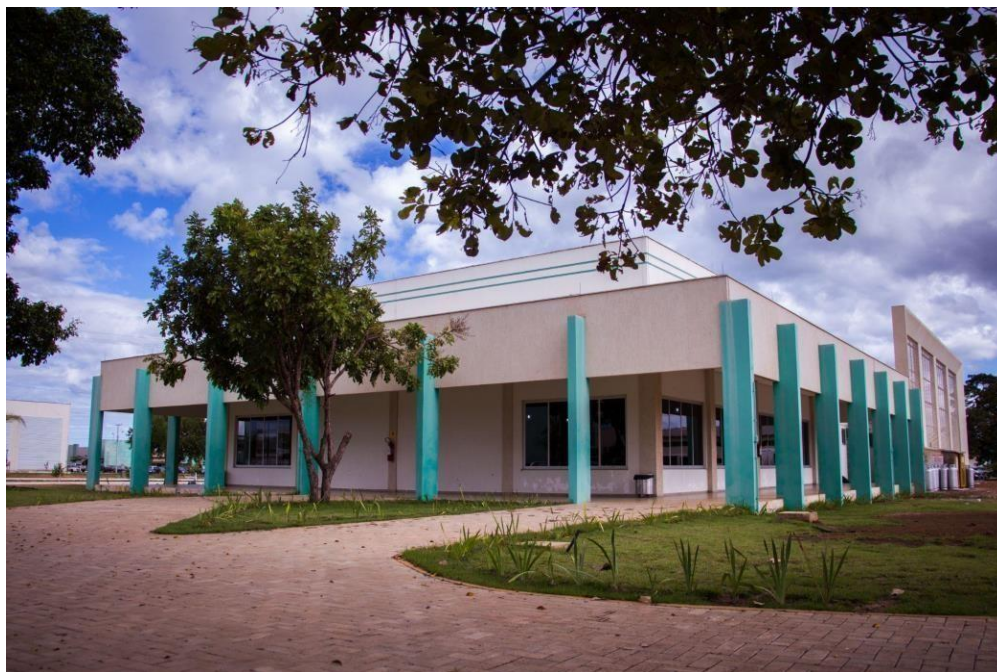
Figura 2 - Instalações do Restaurante Universitário UFT - Campus Palmas
