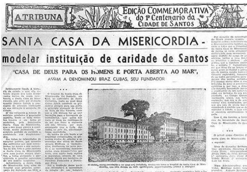
Figura 1 - Santa Casa de Misericórdia de Santos
