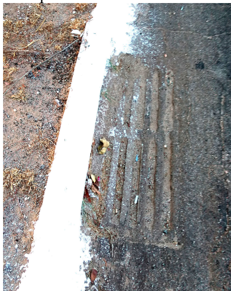
Figura 66: Boca de lobo obstruída por sedimentos
