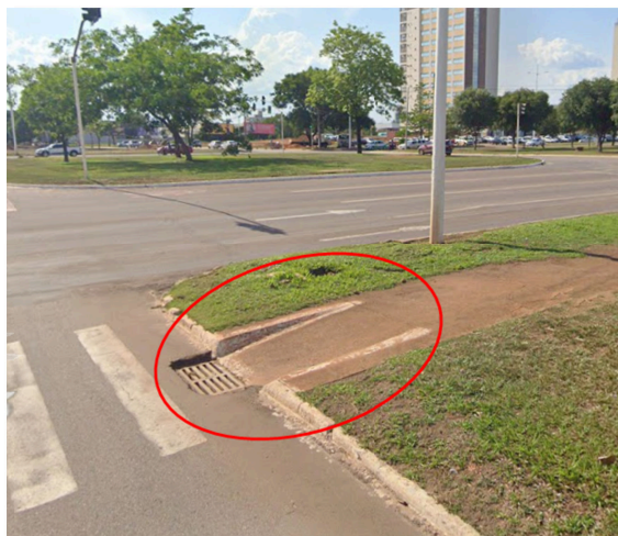
Figura 64: Precariedade das calçadas na Av. Teotônio Segurado: Incompatibilidade entre boca de lobo e rampa
