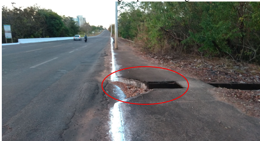
Figura 63: Precariedade das calçadas Av. Teotônio Segurado: Ponto de incompatibilidade com a drenagem para o Córrego
