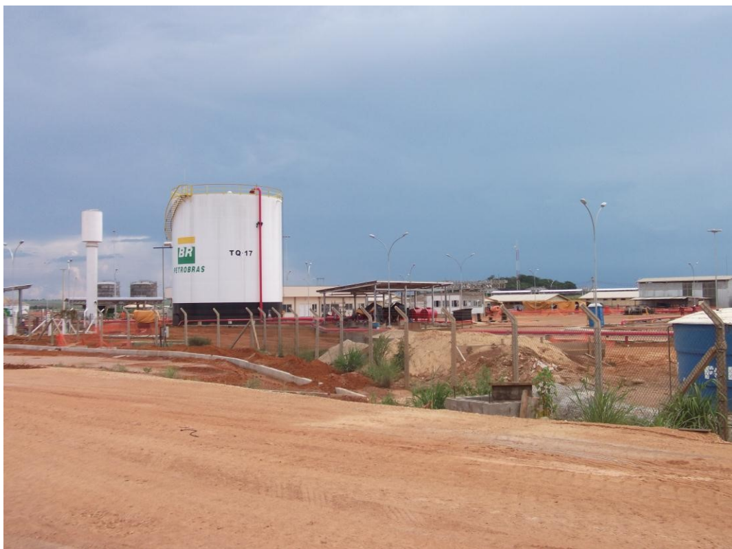
Foto 2 – Canteiro de obras do Pátio Multimodal da Ferrovia Norte Sul, Porto Nacional, com ênfase para os tanques da Petrobrás
