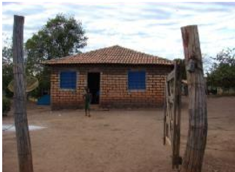
Figura 24 - Frente da casa do Ruimar - Preparação do local.
