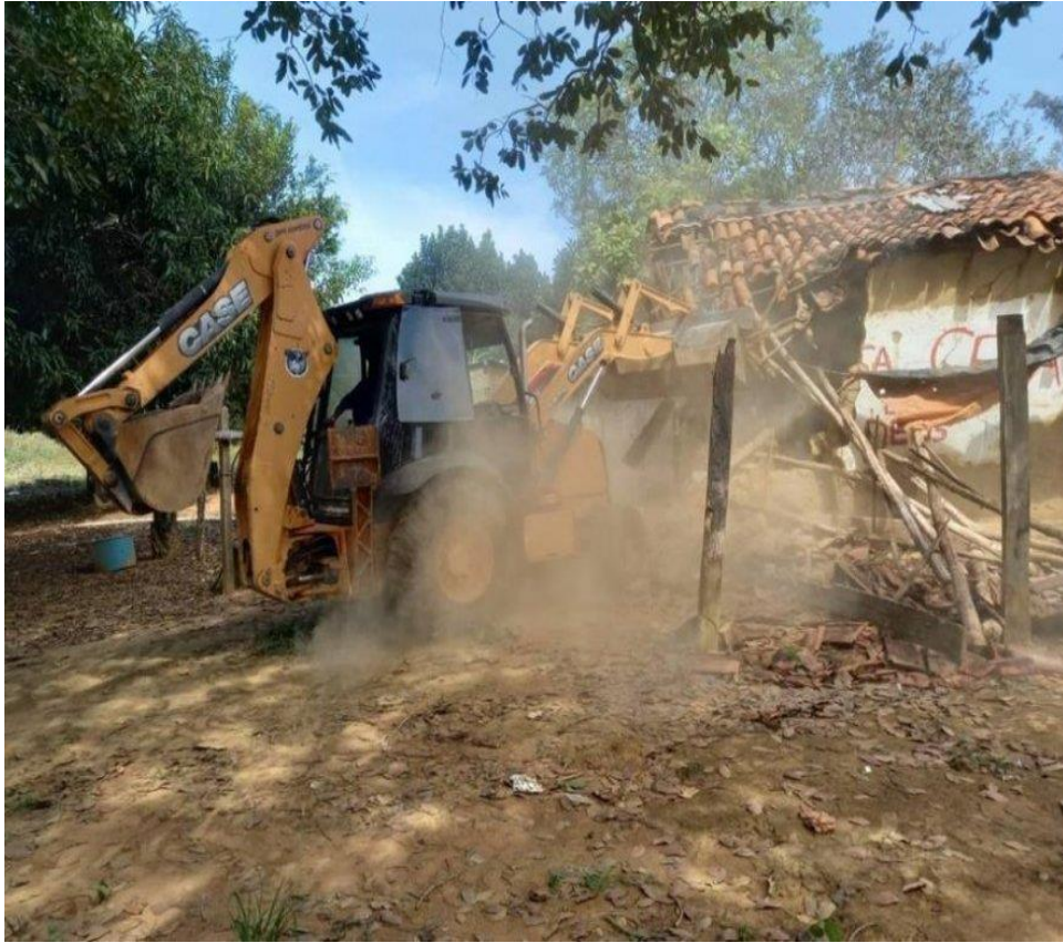
Figura 5 - Máquina destruindo casa durante a desocupação
