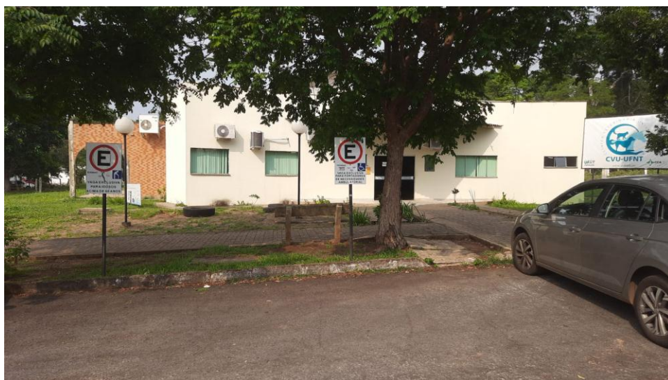
Figura 1. Fachada da Clínica Veterinária Universitária, em Araguaína, TO
