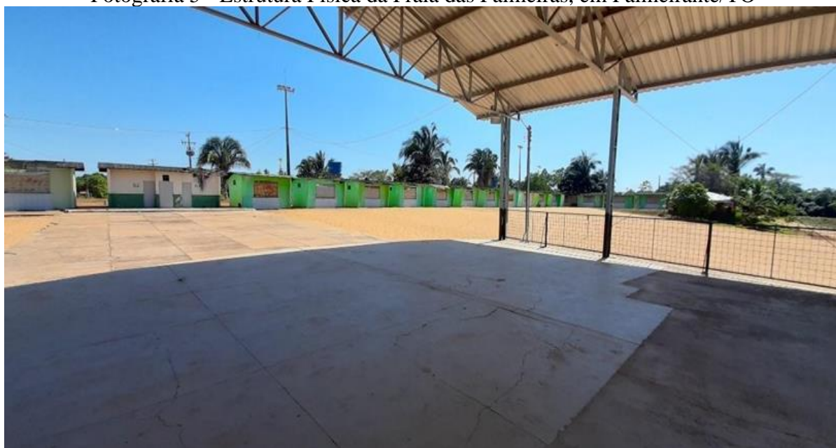
Fotografia 5 - Estrutura Física da Praia das Palmeiras, em Palmeirante/TO
