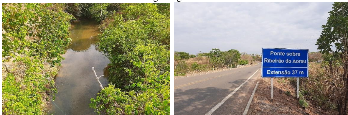
Figura 63 – Ponte sobre o ribeirão do Abreu na TO-110, próximo à área urbana de Taguatinga
