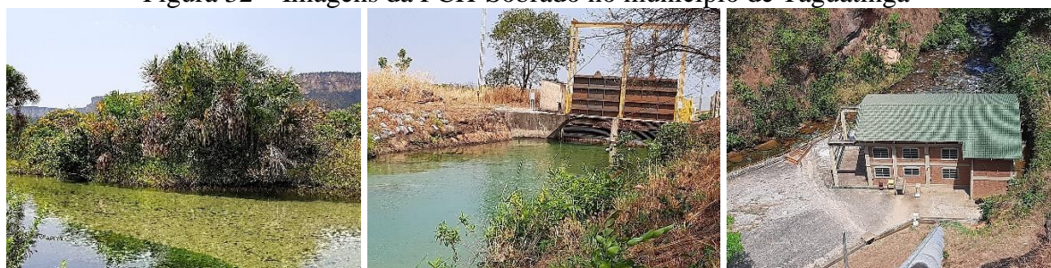
Figura 32 – Imagens da PCH-Sobrado no município de Taguatinga
