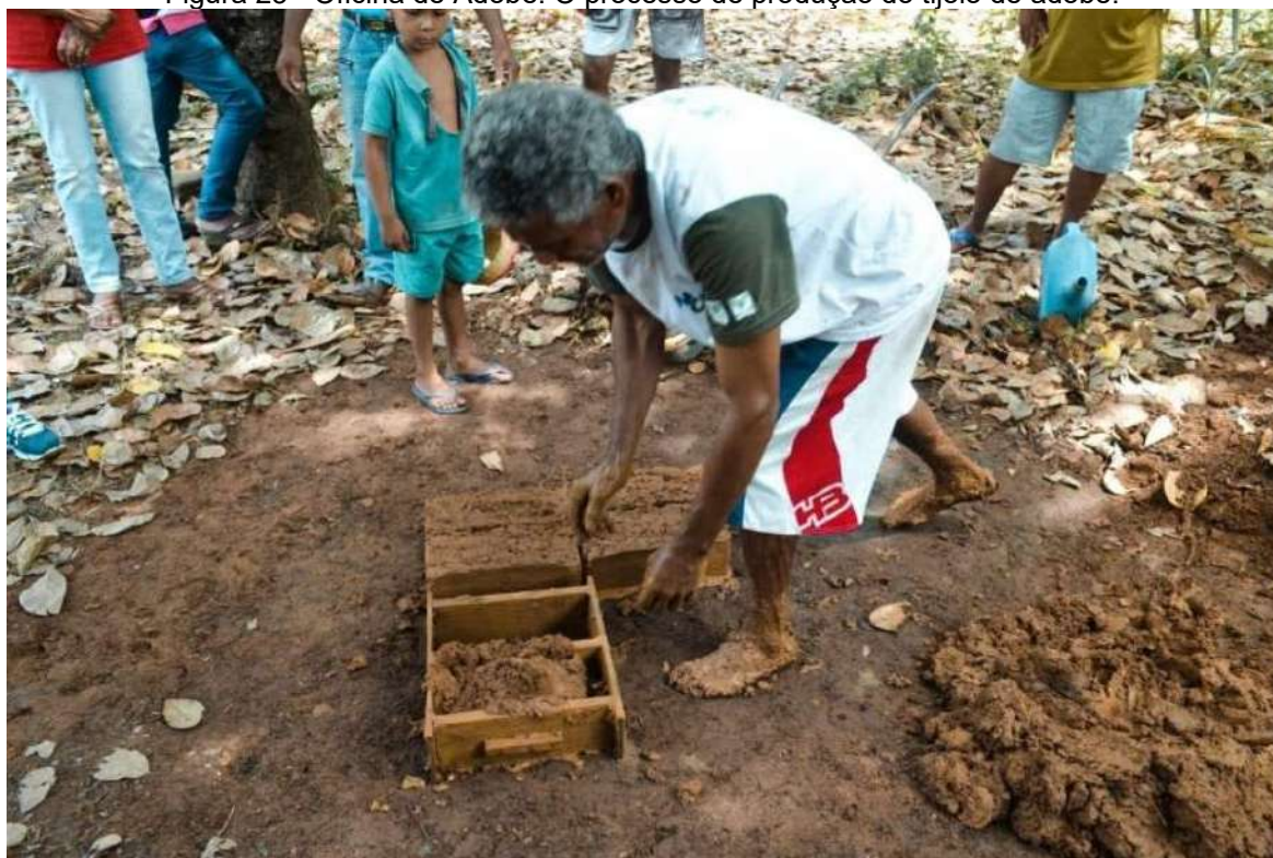
Figura 23 - Oficina de Adobe. O processo de produção do tijolo de adobe.
