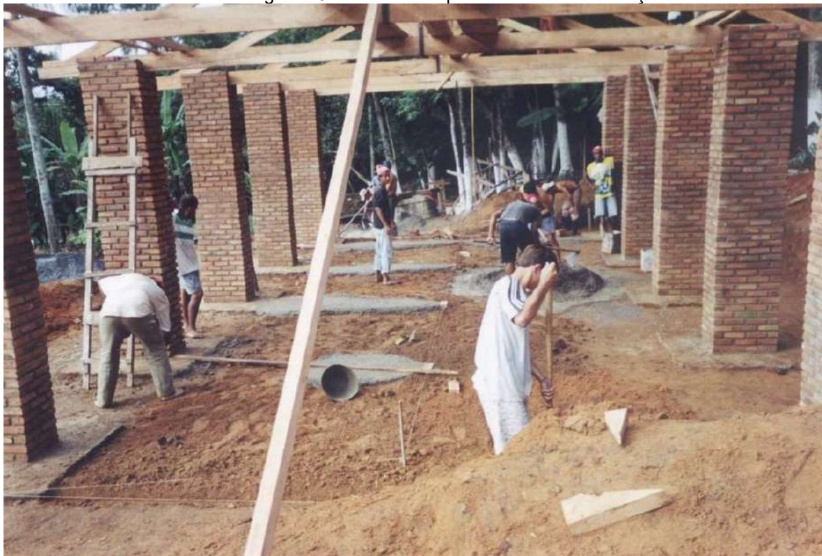
Figura 48 - A escola no período de sua construção
