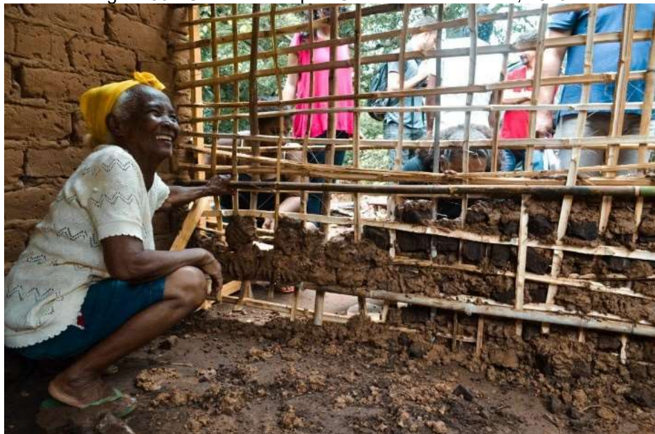
Figura 30 - Oficina de Taipa - Construindo a Parede, 2018.
