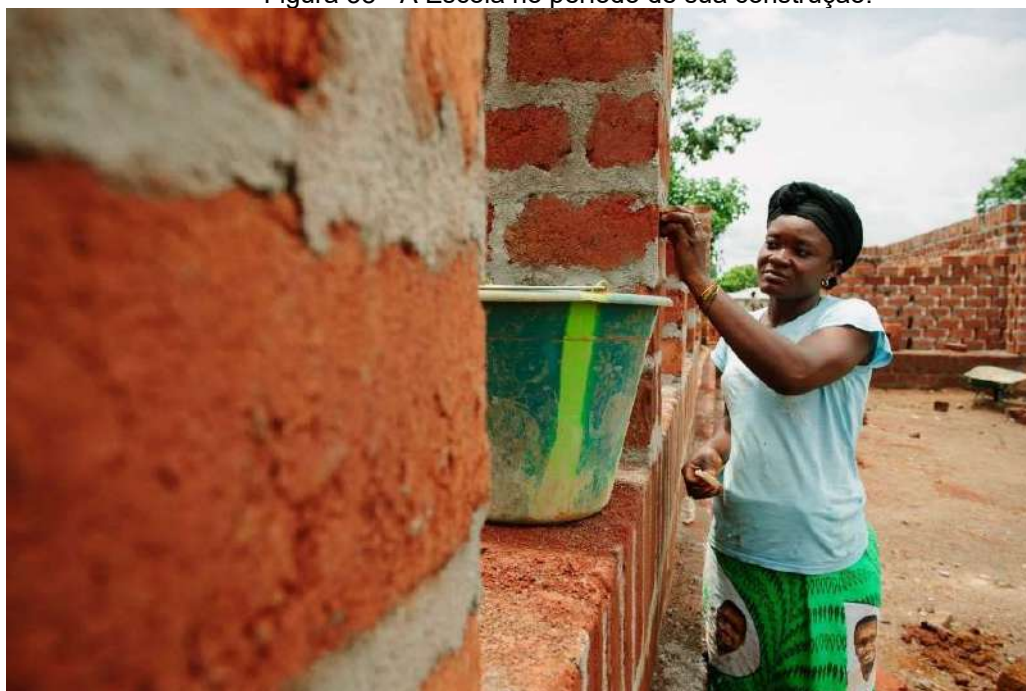
Figura 38 - A Escola no período de sua construção.
