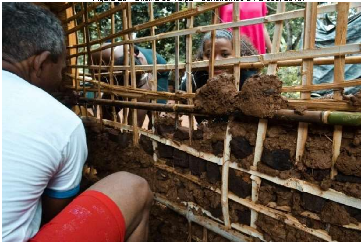
Figura 29 - Oficina de Taipa - Construindo a Parede, 2018.
