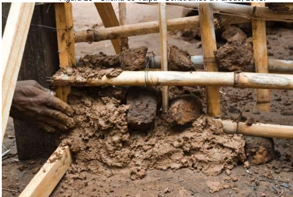
Figura 28 - Oficina de Taipa - Construindo a Parede, 2018.
