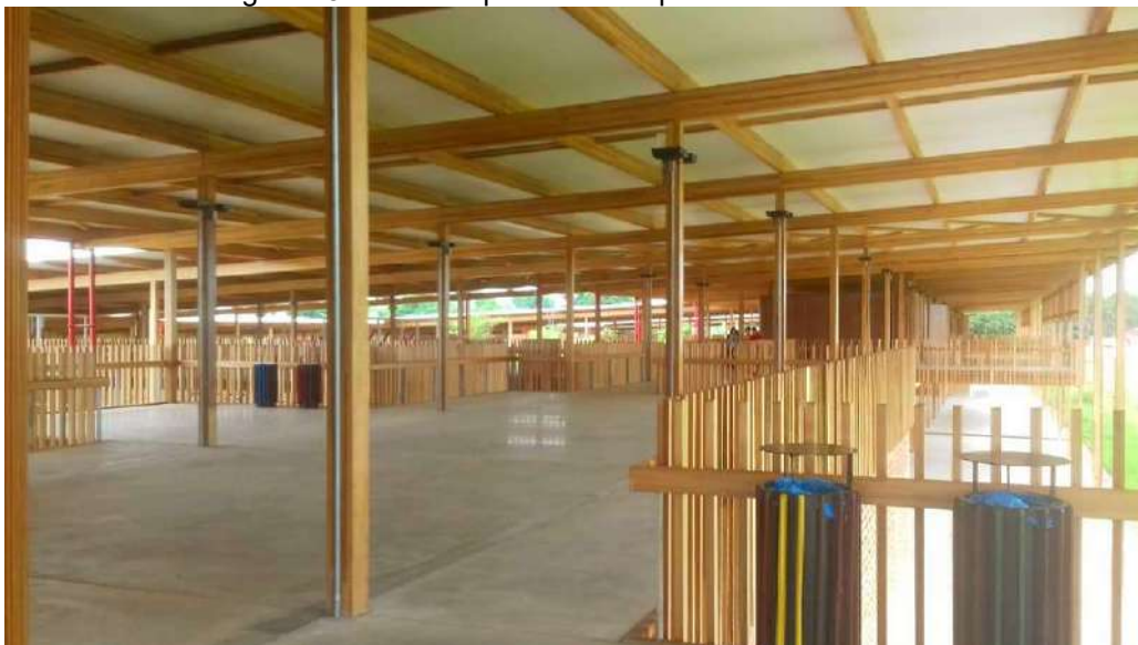
Figura 45 - Vista do pavimento superior de um dos dormitórios.
