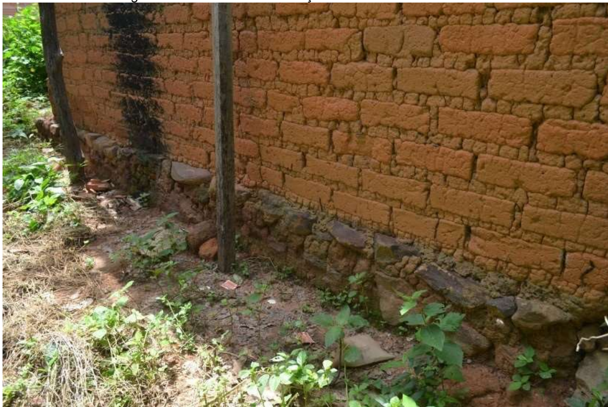
Figura 25 - Detalhe de Construção em Adobe na comunidade.
