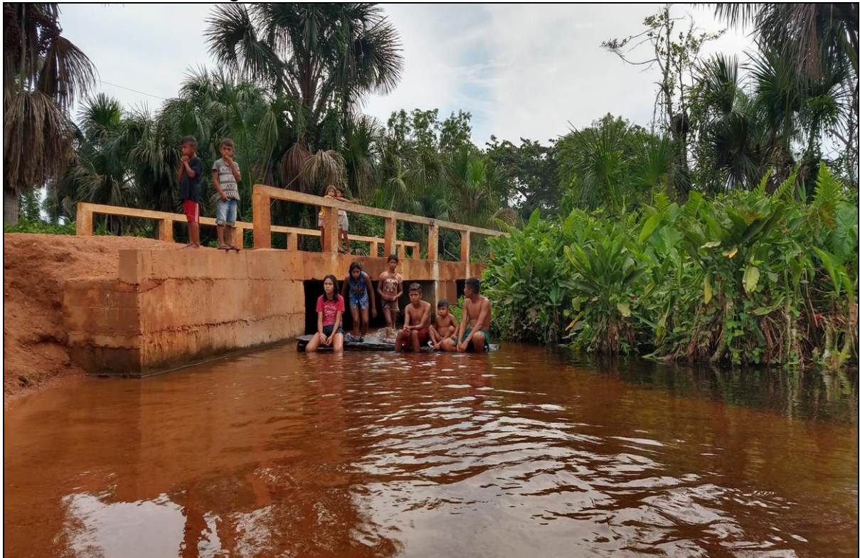
Figura 9 – Ponte sobre o Ribeirão São José
