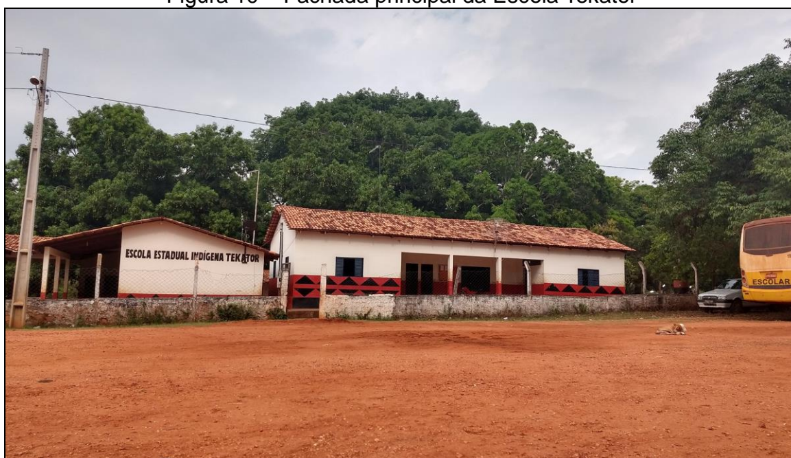
Figura 10 – Fachada principal da Escola Tekator
