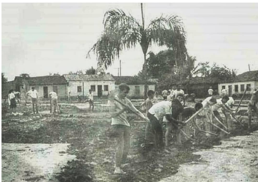
Figura 3: Construção da Praça das Nações
