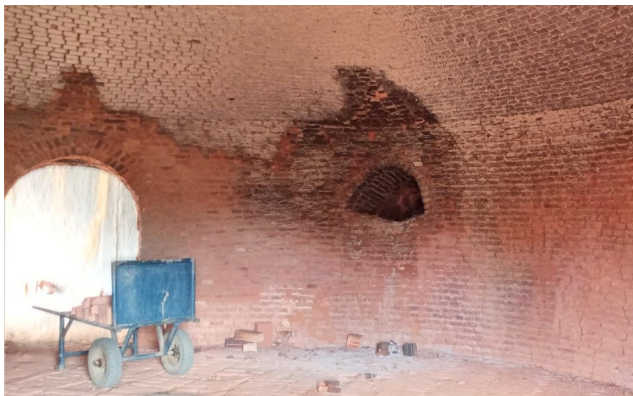
Figura 13: Abertura na parte interior do forno
