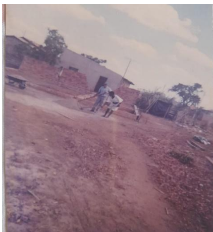
Figura 7: Limpeza dos lotes e construção do alicerce da igreja definitiva
