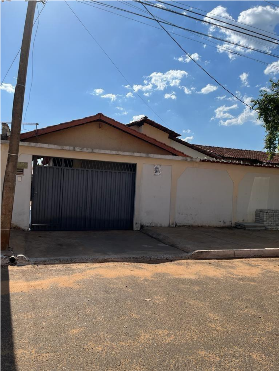
Figura 25 – Casa na Quadra 508 Norte.
