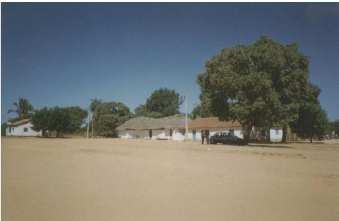
Figura 13 – Casa de alvenaria e telha no povoado Canela.
