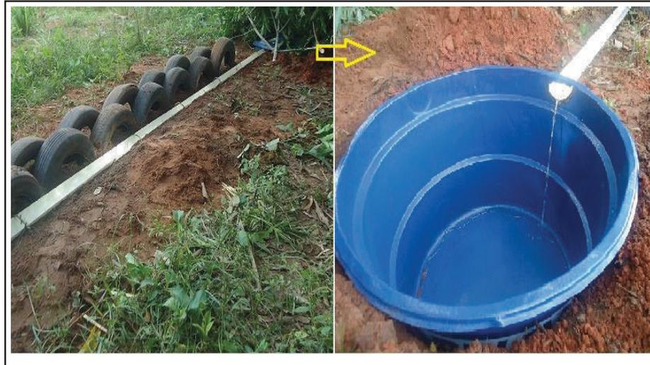
**Figura14:** Calha coletora em PVC com deságue em caixa d'água
