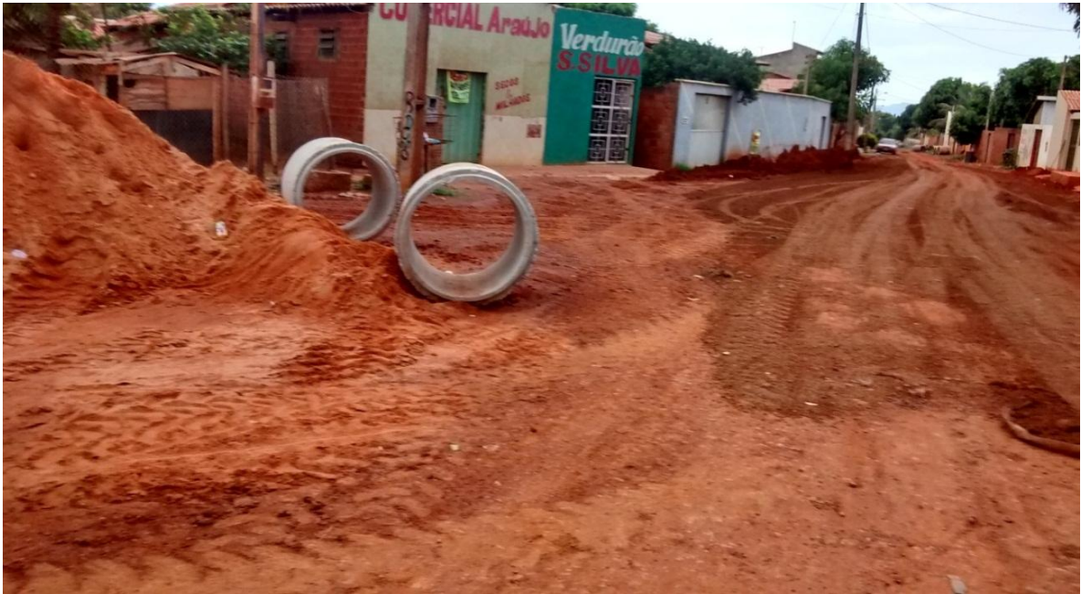
Fotografia nº 03. Obra de pavimentação e drenagem no setor Santo Amaro I
