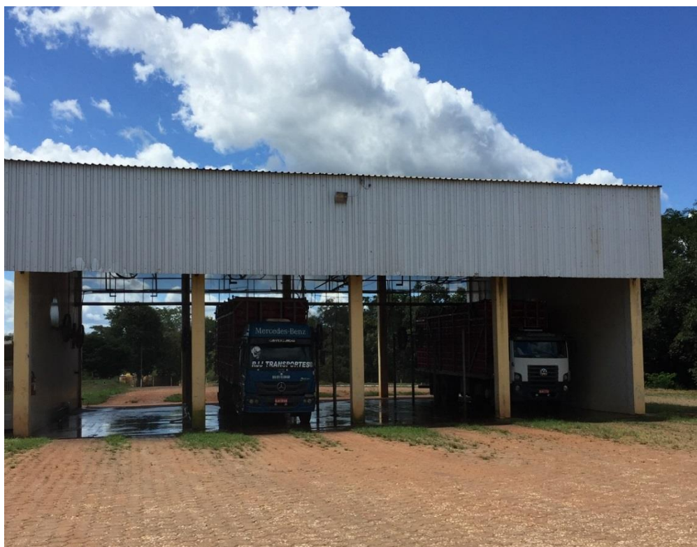
Figura 04: Galpão de descanso dos caminhões.
