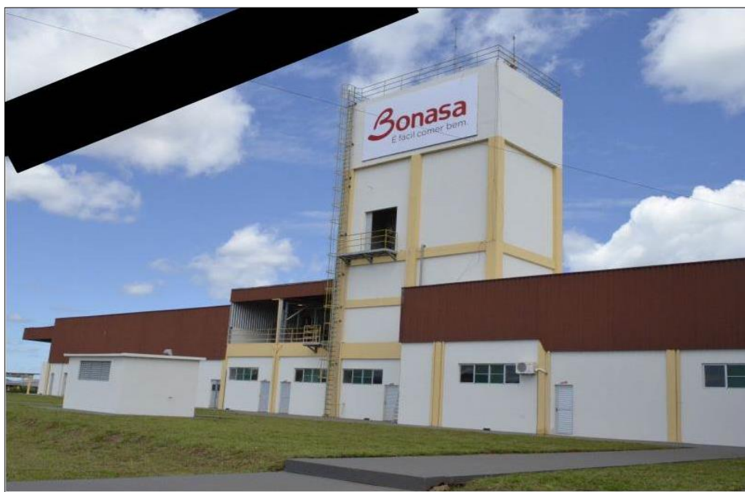
Figura 02: Fachada da planta industrial da empresa Bonasa Alimentos, Aguiarnópolis 2017. Fonte: www.tocnoticias.com.br
