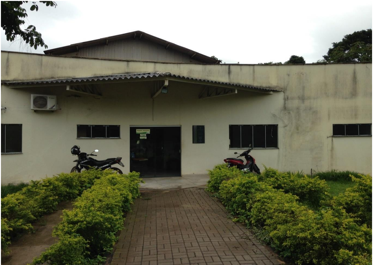
Figura 1. Vista externa do Hospital Veterinário dos animais domésticos, da Universidade Federal do Tocantins (UFT), campus Araguaína. Arquivo pessoal.
