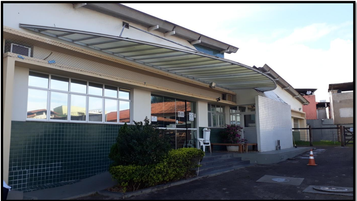
Figura 1: Fachada do Hospital Veterinário Professor Ricardo Alexandre Hippler, da Universidade Vila Velha, Espírito Santo. Fonte: Arquivo Pessoal.
