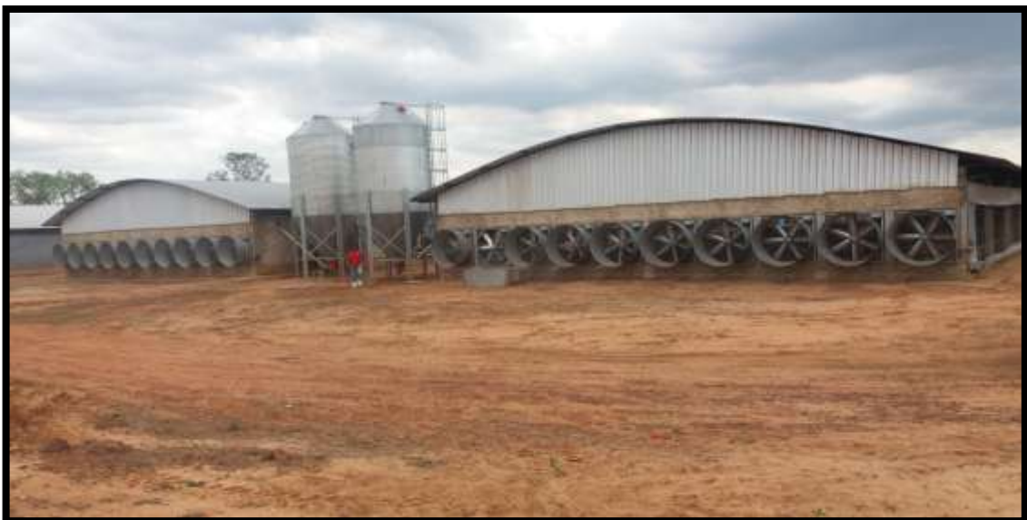
Figura 8 - Lado de fora do galpão.
