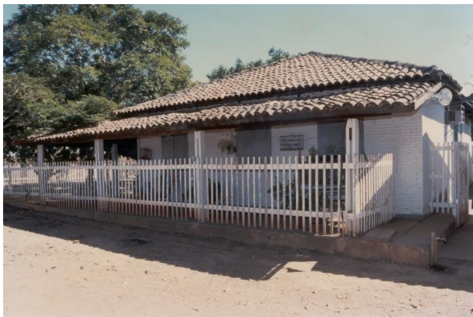
Figura 47 - Fachada sul da casa - janelas de madeira e paredes de adobe
