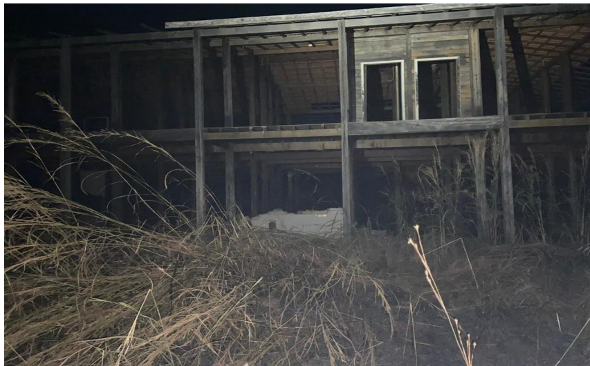
Figura 40 - Incêndio que acometeu a Assembleinha em 2020
