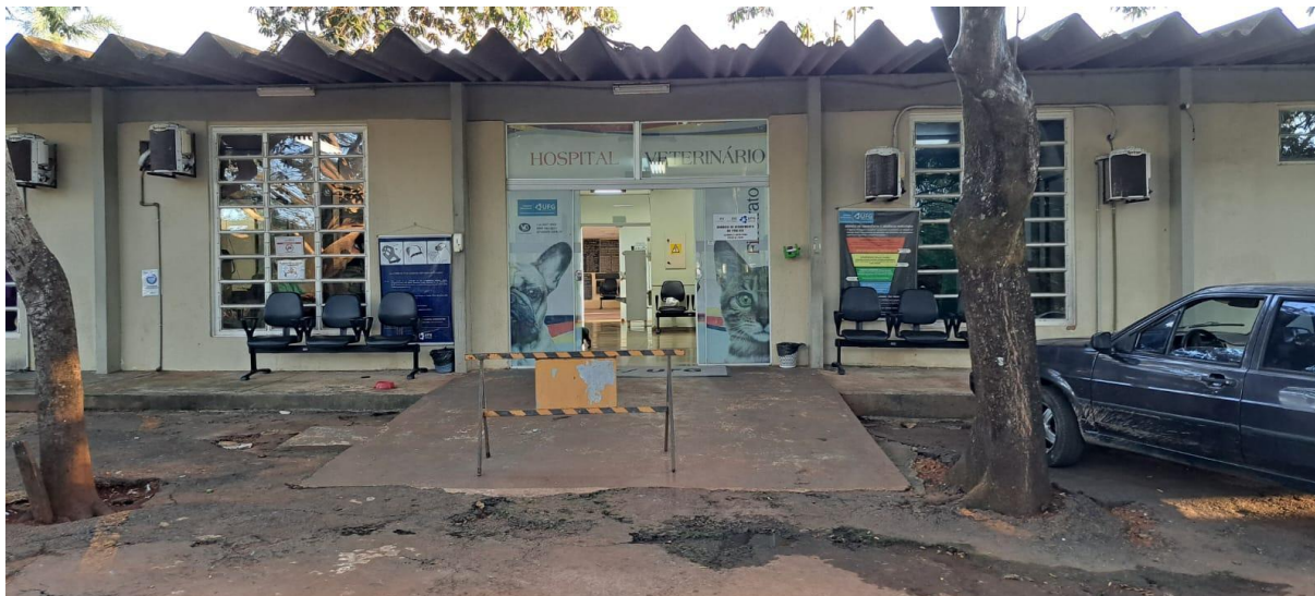
FIGURA 1 - Fachada do HV/EVZ/UFG.
