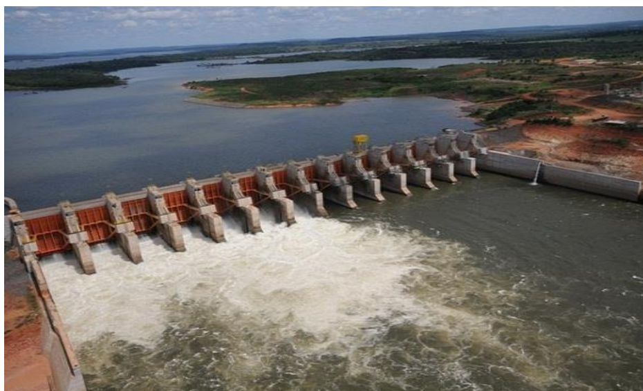
Figura 2: Usina Hidrelétrica de Estreito 4
