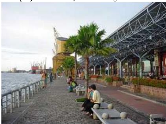
Figura 17 – Estação das Docas, em Belém do Pará, antiga instalação portuária convertida em equipamento de lazer e cultura, aos moldes dos projetos de waterfronts estrangeiros.
