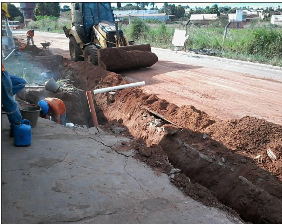
Fotografia 02- Implantação de redes de esgoto no setor Jardim Esplanada
