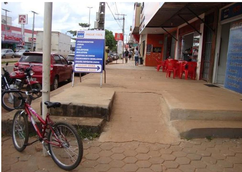
Figura 209 – Exemplo de desalinhamento entre fachadas e adaptação de desnível entre calçadas em Taquaralto. Foto: acervo autora (2015).
